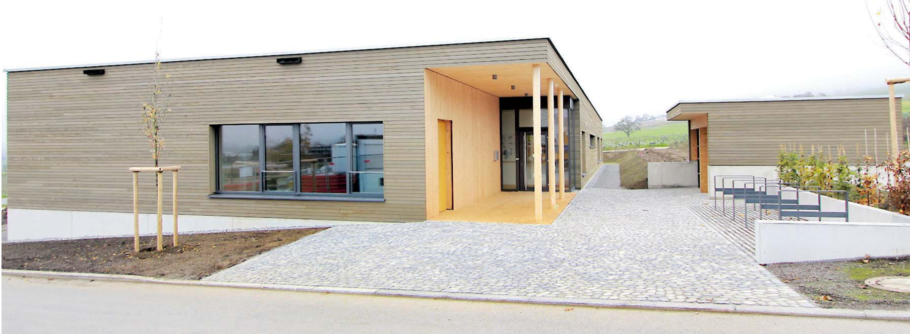
Modern, funktional und einladend ist der Neubau des Kindergartens St. Martin im Neubaugebiet Steppbachwiesle in Hilzingen. In Holzständerbauweise wurde das Gebäude in nur zehn Monaten fertiggestellt.
