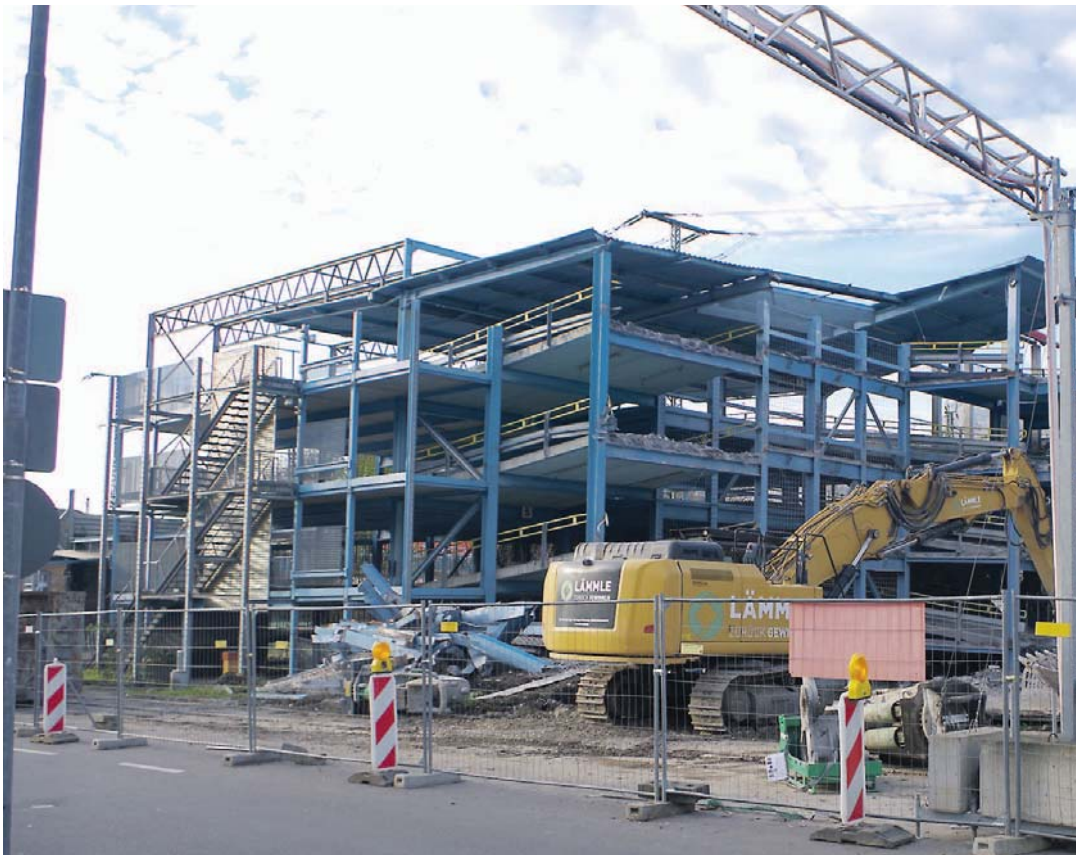
Derzeit herrscht viel Bewegung zum Thema Parkhäuser in Singen. Seit letzter Woche wird das Parkhaus an der Julius-Bührer-Straße nach knapp 30 Jahren rückgebaut und soll durch ein größeres – nichtöffentliches Parkhaus ersetzt werden (im Bild). Ein weiteres großes Parkhaus ist zudem an der Magistraße etwas südlich davon geplant.
