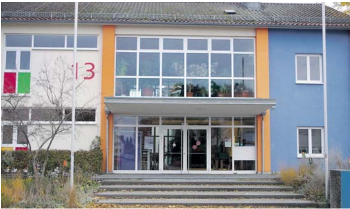
Die geplante Sanierung muss nochmals in die Bewerbungsrunde für Zuschüsse gesetzt werden, weil die Kosten nach genauer Betrachtung erheblich angestiegen sind. swb-Bild: of
