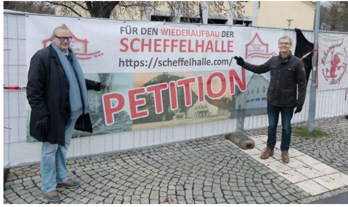
Peter Adrian Gäng, und Karl Mohr Regiocenter-Leiter der Thüga Energie vor der Scheffelhallen-Ruine. swb-Bild: Thüga
