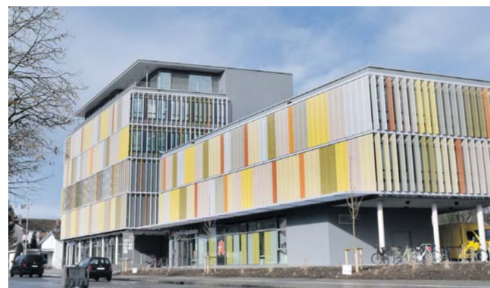
Die charakteristischen, verschiedenfarbigen Lamellen dienen dem Sonnenschutz und können manuell verstellt werden oder von selbst dem Lauf der Sonne folgen.
