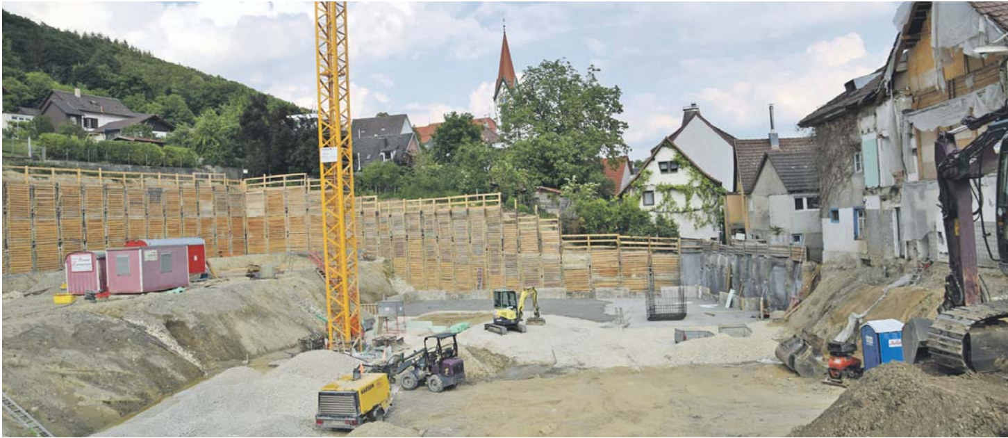
Eine riesige Baugrube klafft hinter dem historischen Gebäude des »Löwen« in der Gailinger Ortsmitte.
