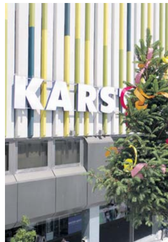
Hinter dem Richtbaum wird gerade in das Warenhaus Karstadt gerungen. swb-Bild: of
