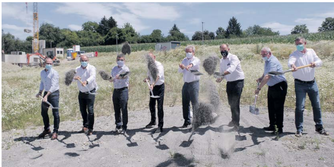
Corona-konform mit Masken, um damit etwas dichter stehen zu können, wurde der Spatenstich für die neue DRK-Rettungswache am Donnerstag vollzogen. sub-Bild: of
