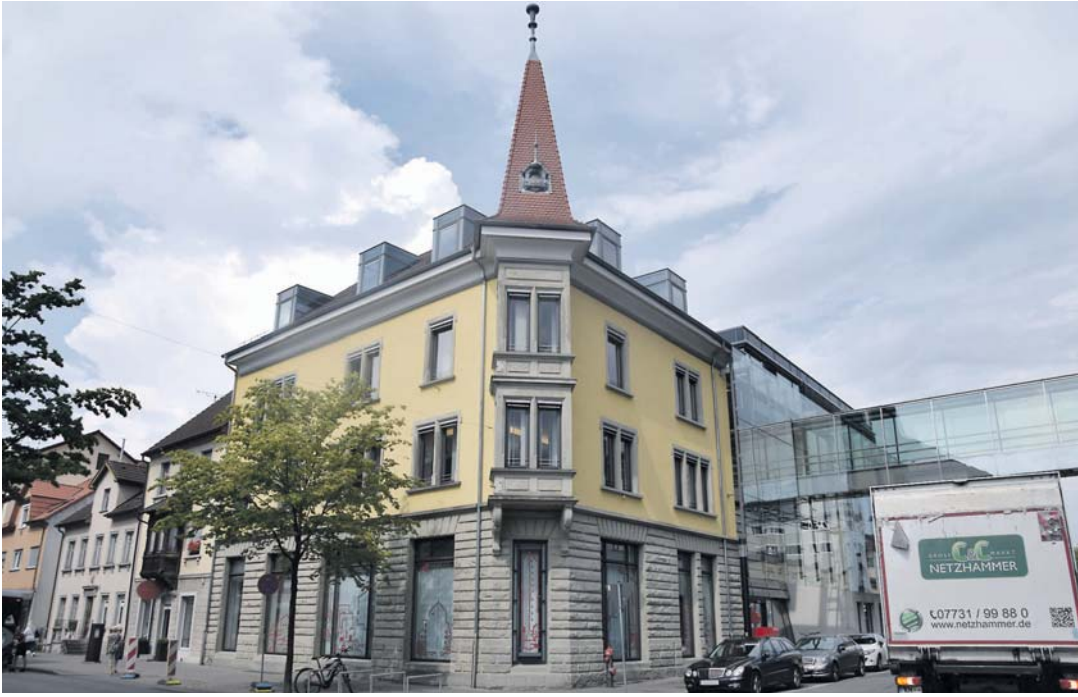
Das historische Eckgebäude der Sparkasse aus der Gründerzeit mit modernem Anbau ist ein gelungenes Beispiel für den Erhalt ortsprägender Bauten.
