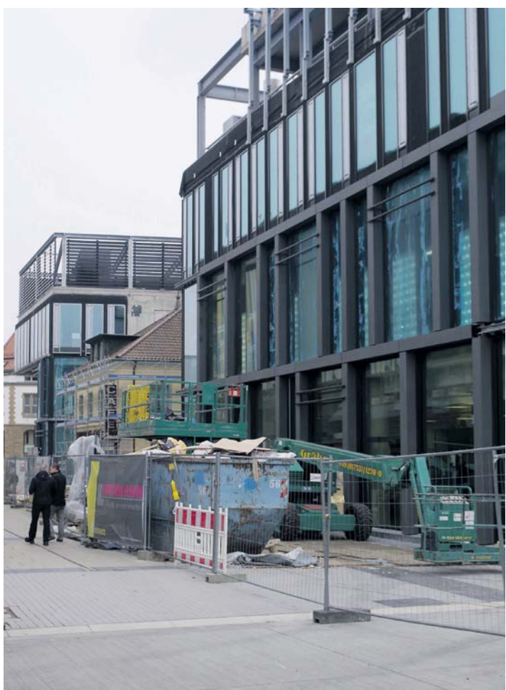
Die Baustelle des CANO am Singener Bahnhofsplatz ist noch hermetischer abgeriegelt und bewacht.
