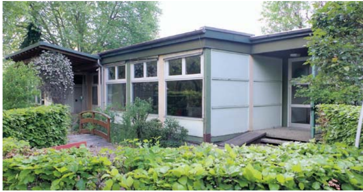
Für drei Kinderbetreuungseinrichtungen hat der Verwaltungs- und Finanzausschuss in seiner jüngsten Sitzung Mittel für zusammen rund 3,2 Millionen von der gesetzten Haushaltssperre befreit, unter anderem für den Ersatzneubau des Waldorfkindergarten auf dem früheren Areal des Schulkindergartens am Lindenhain. swb-Bild: of
