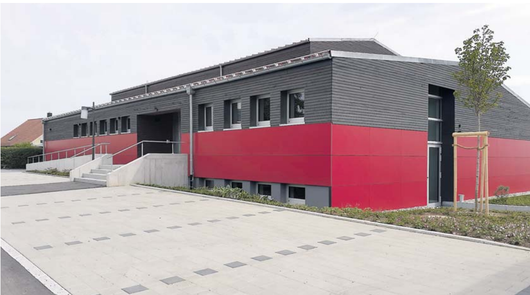
Ein Hingucker in Bittelbrunn: die frisch sanierte Petersfelshalle.
