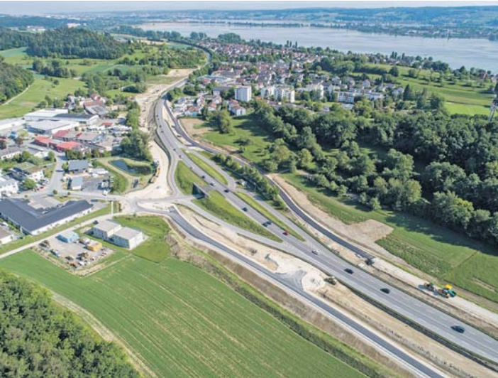
Die Situation rund um die Abfahrt Allensbach-Mitte wird sich in den nächsten Wochen stark verändern – bis im September die Anschlussstelle nebst Brücke neu erstellt ist. swb-Bild: RPF
