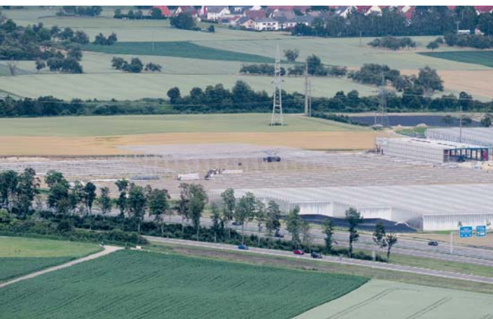
Die Baustelle für die Erweiterung des Gewächshauskomplexes bei Singen-Beuren vom Hohenkrähen aus gesehen. swb-Bild: of
