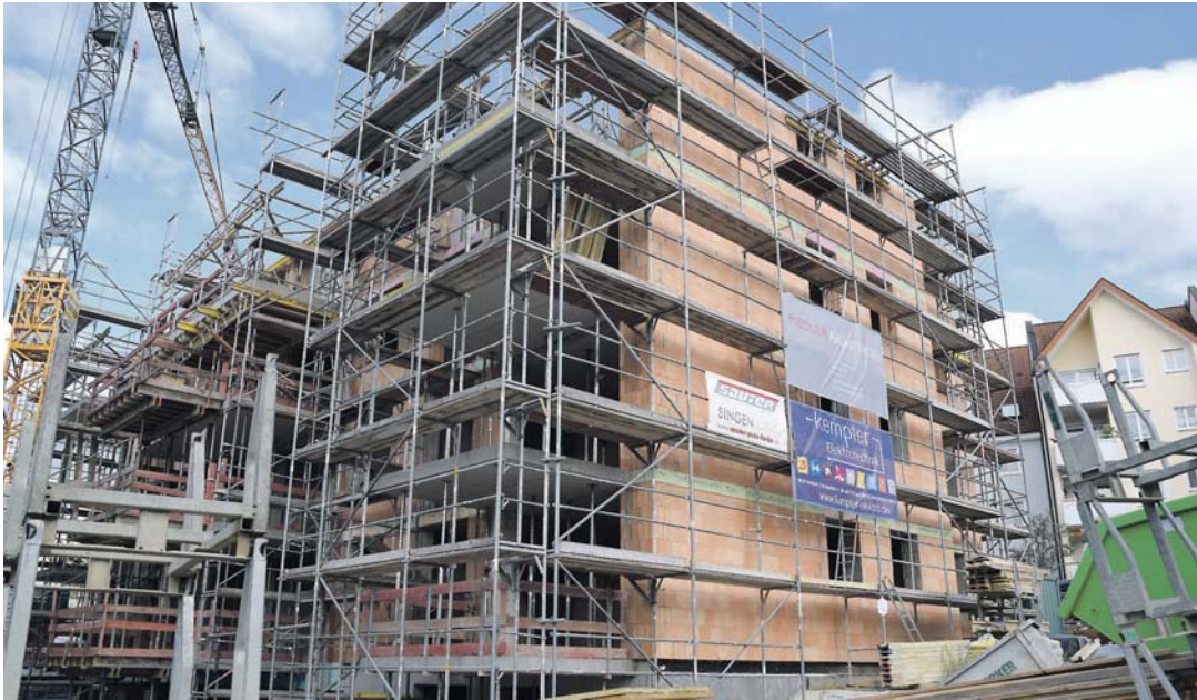
Aktuell laufen die Bauarbeiten für das Projekt Galgenacker 22 auf Hochtouren.
