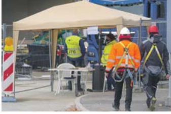
Zugang zur Baustelle gibt es nur noch über einen »Point of Care«.
