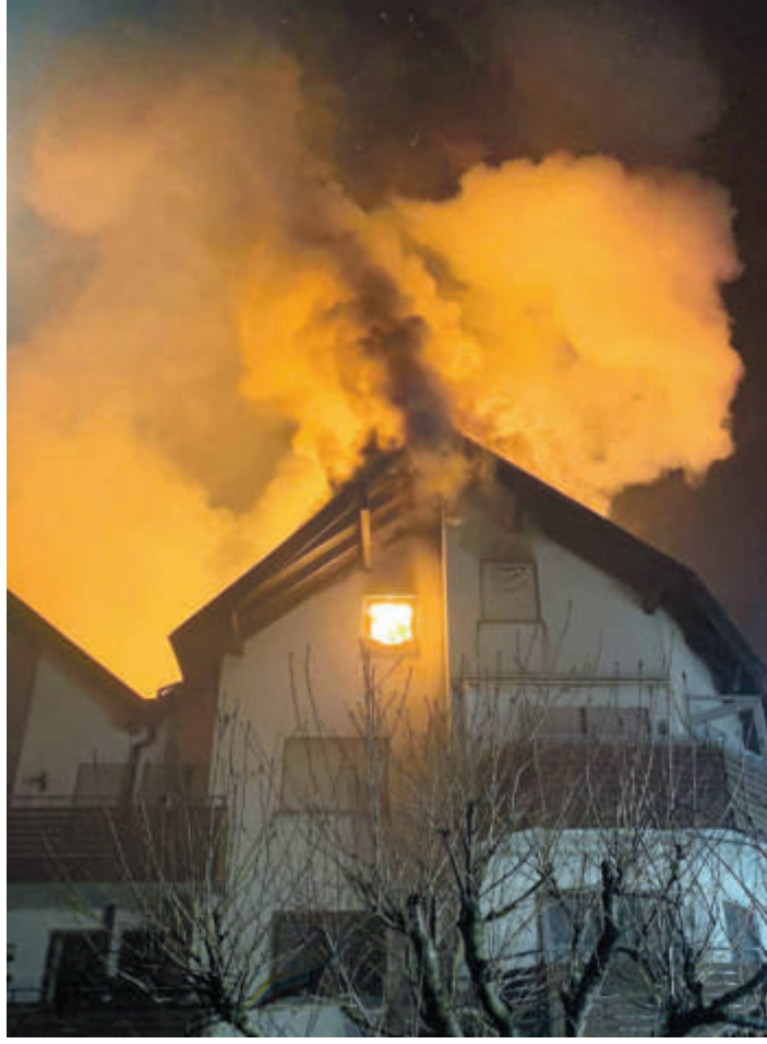
Die Konstruktion des Daches erforderte den Einsatz von zwei Drehleitern um den Dachstuhlbrand von zwei Seiten bekämpfen zu können. swb-Bild: FFW Rielasingen-Worblingen
