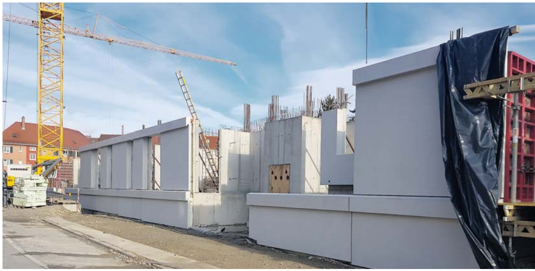
Die ersten Fertigbaubetonenelemente deuten an, wie die Praxedisgärten aussehen werden. subw-Bild: Baugenossenschaft Hegau
