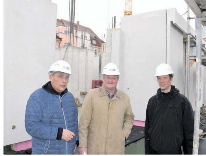
Auf der Baustelle der Praxedisgärten. In der Mitte der geschäftsführende Vorstand der Hegau Baugenossenschaft, Axel Nieburg, sowie Projektleiter Udo Tischer (links) und Architekt Kai Feseker. subw-Bild: stm
