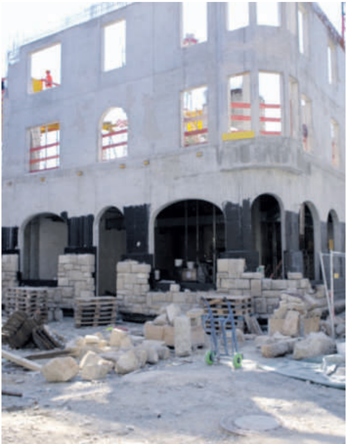
Die Rekonstruktion des ehemaligen Hotel Victoria hat in der vergangenen Woche auf der Cano-Großbaustelle begonnen. swb-Bild: of
