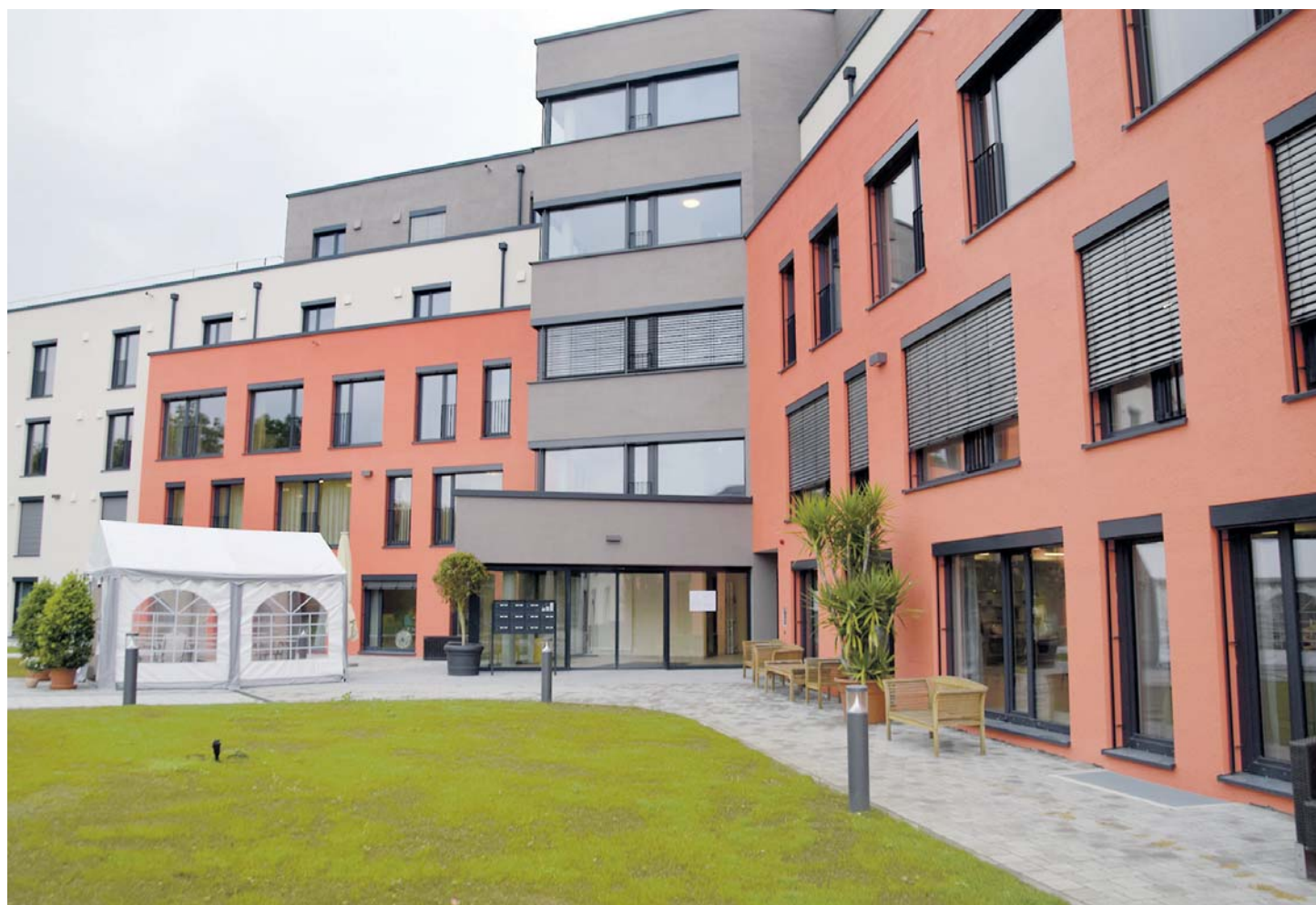
Das neue Seniorendomizil am Hewen ziert Engens Ortseingang.
