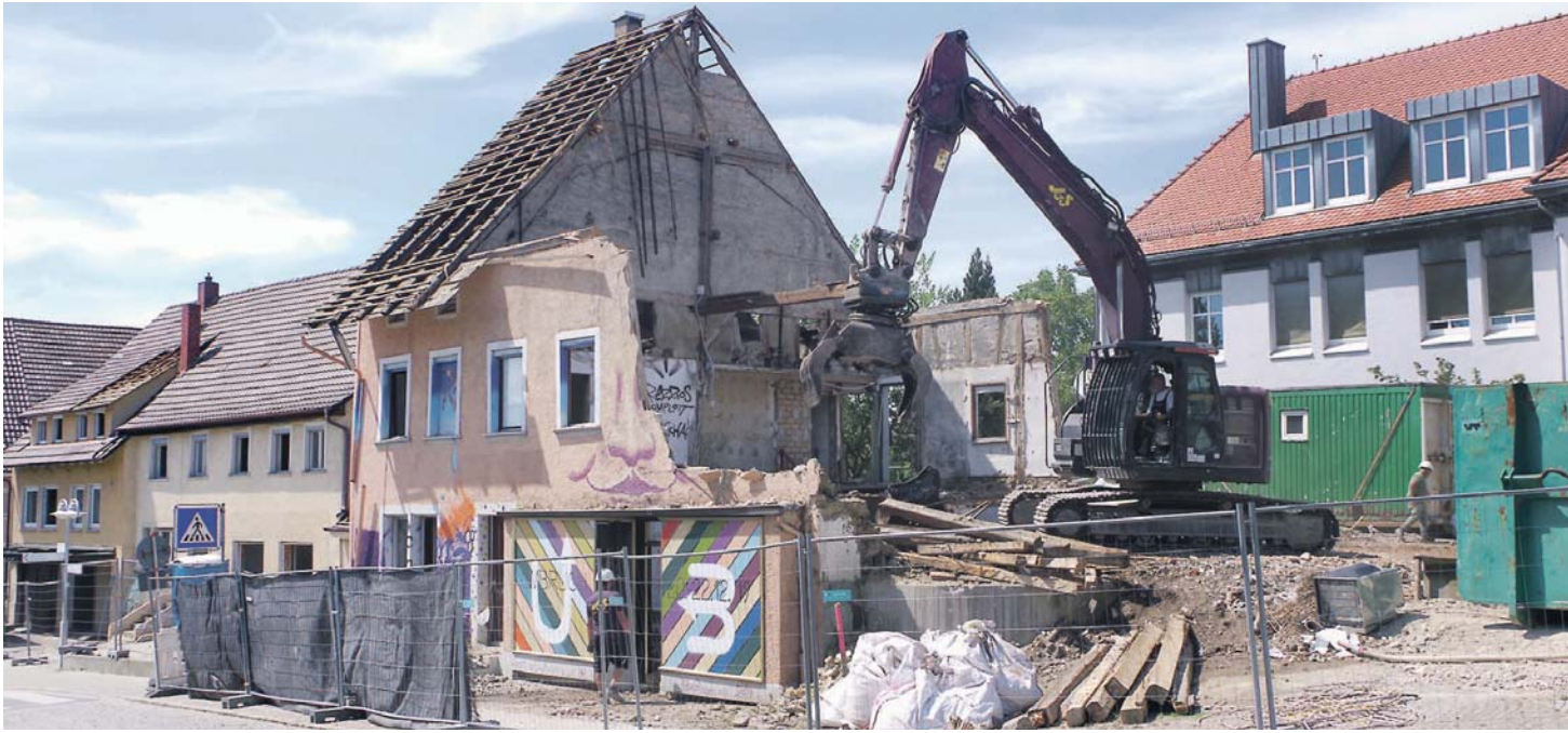
Nach diversen Vorarbeiten wie der Entfernung von Eternit-Verkleidungen hat nun der Abriss der Gebäude des Ensembles an der Langestraße begonnen, auf dem dann das Steißlinger Ärztezentrum entstehen soll. Noch etwa drei Wochen wird der Rückbau dauern, an dem schon vor Ort die Materialien getrennt werden durch viel Fingerspitzengefühl der Baggerführer.
