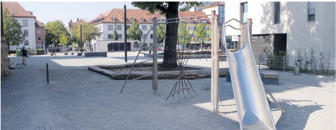
Der neue Herz-Jesu-Platz, sorgt ein Jahr nach der Fertigstellung für generierte Anwohner durch man-gelnde Manieren der Nutzer.
