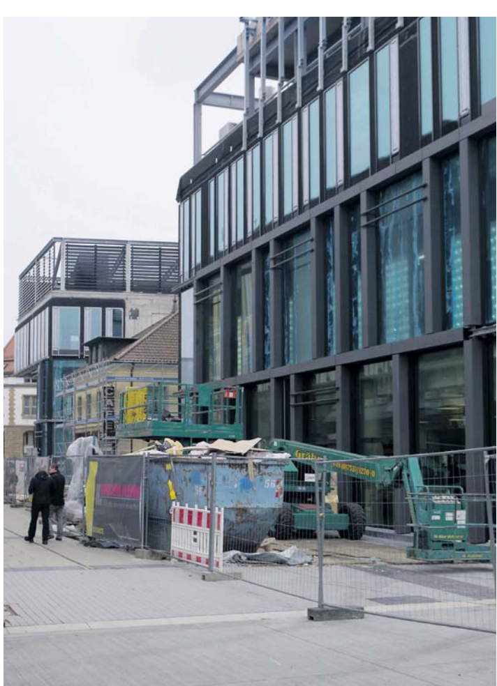
Die Baustelle des CANO am Singener Bahnhofplatz ist noch hermetischer abgeriegelt und bewacht.
