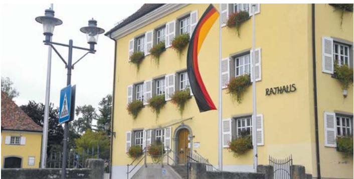
Die Gemeindeverwaltung gibt grünes Licht für den weiteren Bauabschnitt im Rahmen der Ortskernsanierung. swb-Bild: mu
