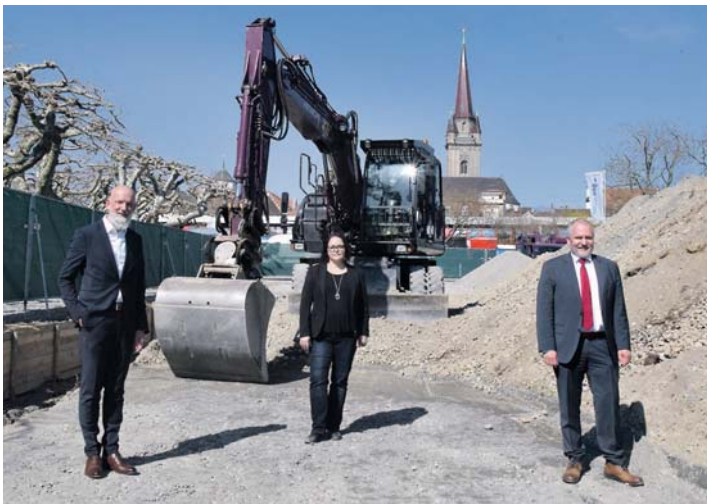
Dr. Norbert Reuter, Geschäftsführer der Stadtwerke Radolfzell, Projektleiterin Katja Romer und der Radolfzeller OB Martin Staab bei der Baustellenbegehung zum Baustart für das neue Gastronomiegebäude an der Mole.
