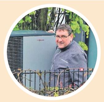
Ingo Arnold Handwerksmeister im Sanitär- Heizung-Klima-Handwerk in Singen
