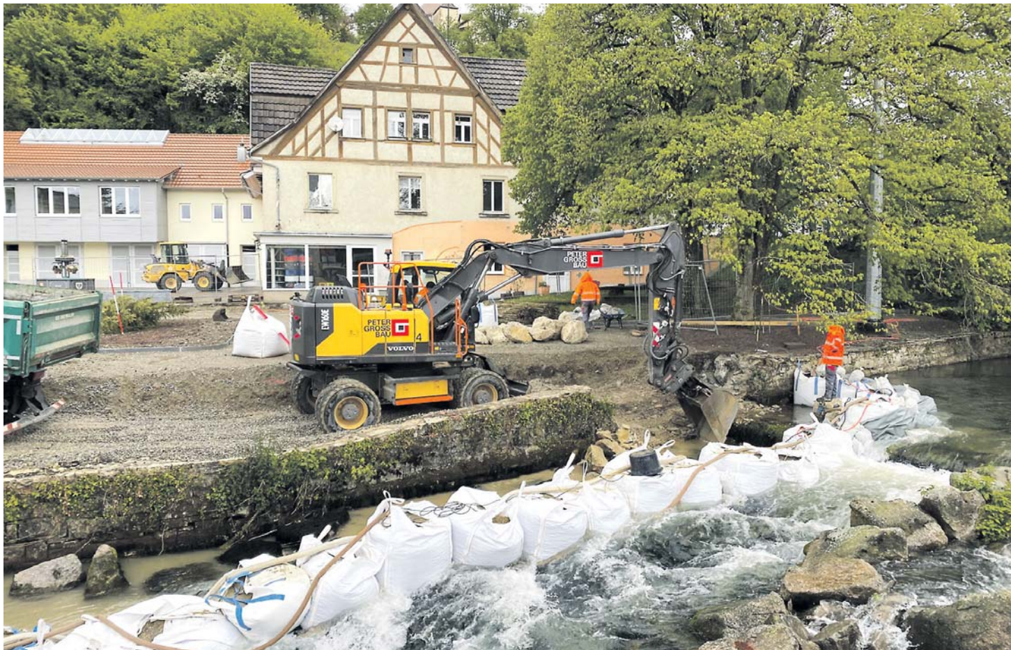
Im Herzen von Aach wird kräftig gebaggert und geschafft, damit die Stadt ein neues Gesicht bekommt.
