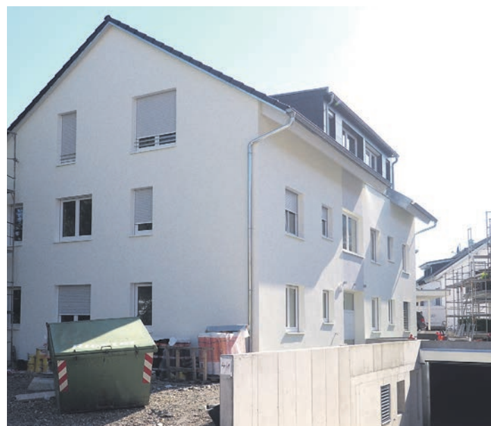
Die Neubauten entsprechen dem KfW-55-Standard. Rechts auf dem Bild ist die Einfahrt zur geräumigen Tiefgarage zu sehen. Der Bereich darüber soll später begrünt werden.
