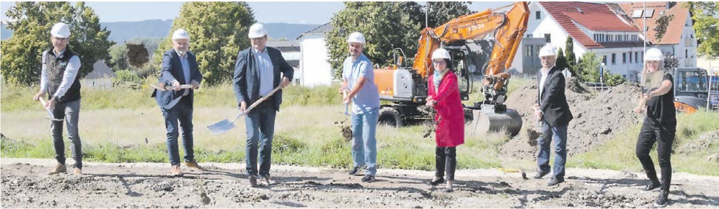
Markus Kaltenstadler von der Rohbaufirma Stocker, Oberbürgermeister Martin Staab, Ortsvorsteher Lorenz Thum, Michael Jentsch, der erste Vorsitzende des Sportvereins Markelfingen, Bürgermeisterin Monika Laule, Projektleiter Engin Ersoy und Architektin Birgit Wohlfart vom Architekturbüro Steimle beim Spatenstich für die neue Markolfhalle.
