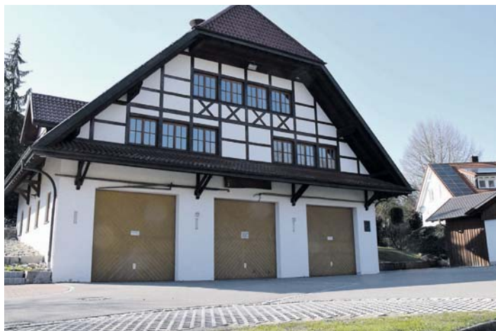
Das Feuerwehrhaus in Schienen soll auf der Nordseite, im Bild rechts zwischen Feuerwehrhaus und Traföhäuschen am rechten Bildrand, einen Anbau mit Umkleide- und Duschmöglichkeiten bekommen. swb-Bild: dh
