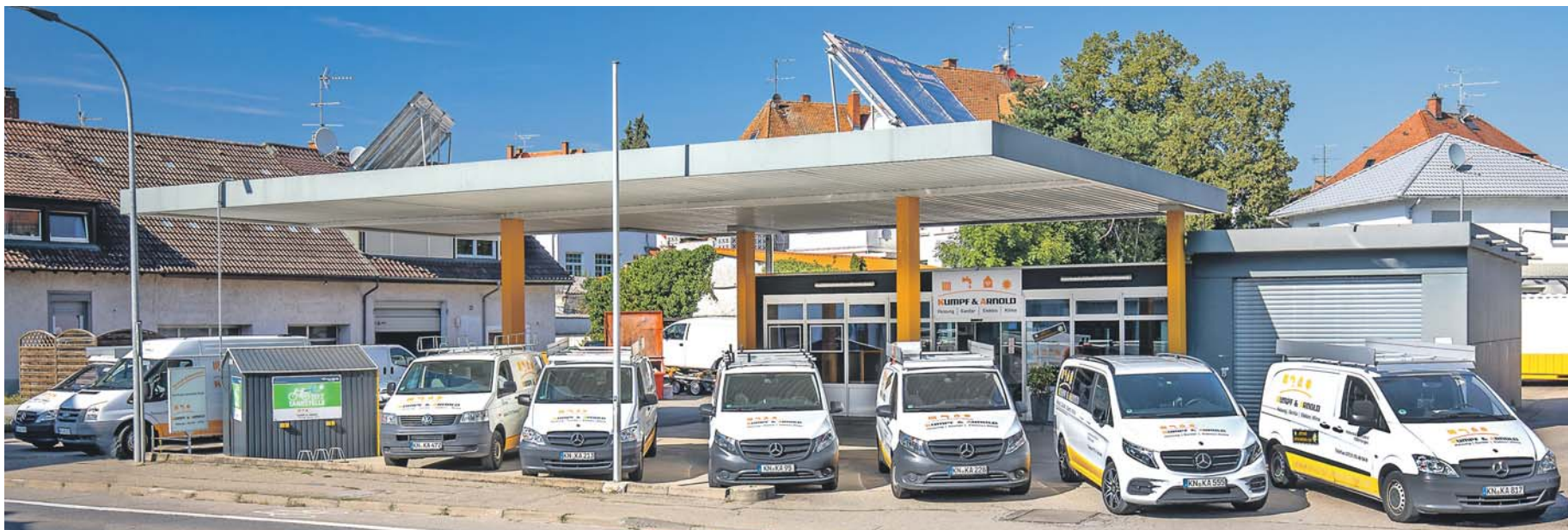
Seit einem Jahrzehnt ist die Firma Kumpf & Arnold in der Hohenkrähenstraße 4 in Singen ansässig. 23 MitarbeiterInnen sind als Monteure, im Kundendienst und in der Verwaltung für das Unternehmen tätig und im ganzen Hegau unterwegs. Dank Erfahrung, Fachwissen, ständiger Weiterbildung und der Begeisterung fürs Handwerk ist der Meister- und Ausbildungsbetrieb für Heizung, Sanitär und Klimatechnik bestens für die Zukunft aufgestellt. swb-Bild: Arnold
