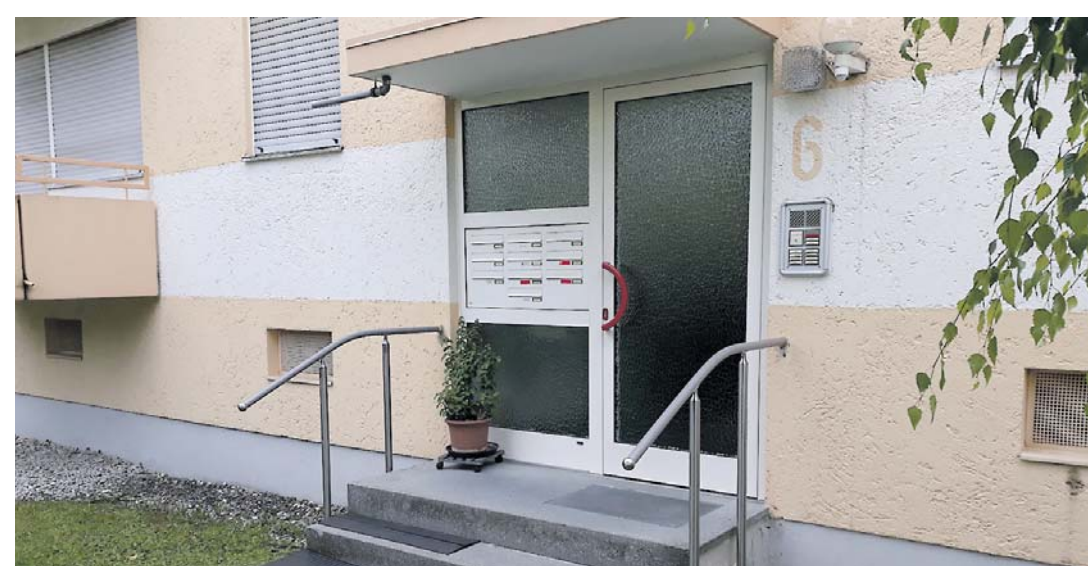
Auch hier wurde nachgerüstet: Beidseitiger Handlauf, so geht Treppen steigen heute
