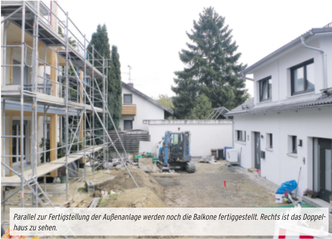
Die Aktivierung einer Baulücke für Wohnungsbau durch einen privaten Investor ermöglichte die Schaffung eines Wohnhauses und einem Doppelhaus durch das Unternehmen Burkhard Hausbau/Renchen - es ist ein Holzständerbau. swb-Bilder: of
