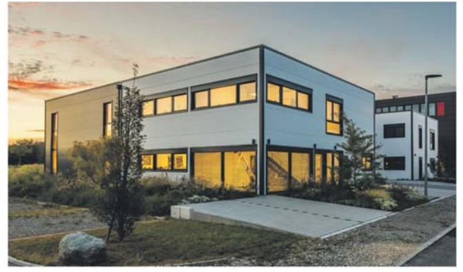
Unternehmen sind ebenfalls bestens bei Team HAUS aufgehoben, in diesem Fall in nachhaltiger Bauart mit Holz statt Stahl ausgeführt.
