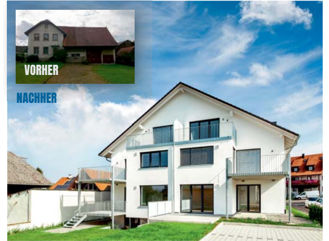
Alten Grundstücken haucht Team HAUS neues Leben ein. Eine baufällige Scheune wurde entfernt und ein Neubau bietet nun sieben Familien moderne Wohnungen.
