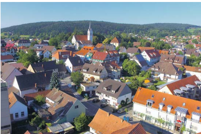
Die Erneuerung des Steißlinger Ortskerns wird durch das Städtebau- programm des Landes unterstützt. Das Bild entstand noch vor dem Abriss am Kreisel Ortsmitte für das Gesundheitszentrum, das Teil des Sanierungsgebiets ist. swb-Bild: Gemeinde
