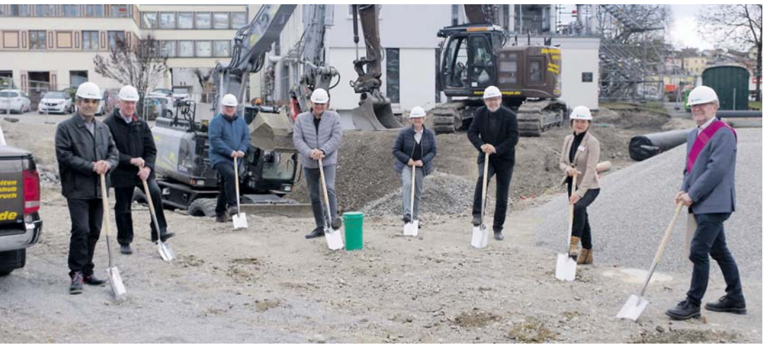
Spatenstich auf Abstand mit Baustellenleiter Abdolhamit Norozi vom Unternehmen Stocker, Franz Duffner als Sprecher der Mitgliederversammlung des Trägervereins, Bürgermeister Ralf Baumert, Bauleiter Michael Graf, Heimleiterin Gisela Messmer, Jürgen Stockmann als Vorsitzender des Trägervereins, Pflegedienstleiterin Vera Zinsmayer-Keller und Diakon Wilfried Ehinger.
