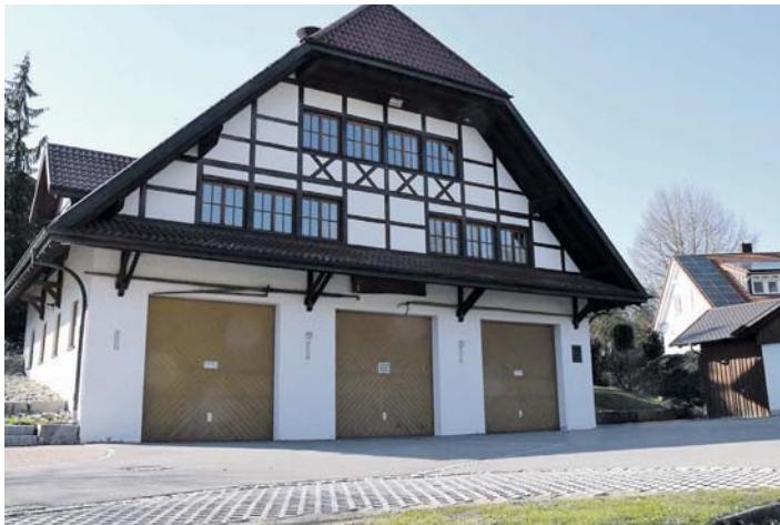
Das Feuerwehrhaus in Schienen soll auf der Nordseite, im Bild rechts zwischen Feuerwehrhaus und Trafohäuschen am rechten Bildrand, einen Anbau mit Umkleide- und Duschmöglichkeiten bekommen. swb-Bild: dh
