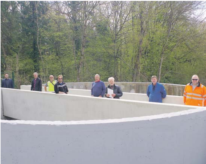
Am Ziel angekommen ist nach vier Jahren das Abwasserprojekt der Gemeinde Hohenfels. swb-Bild: of
