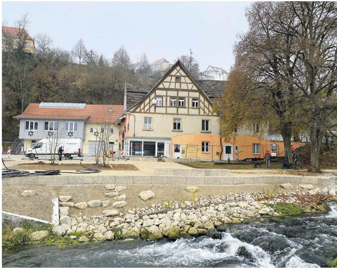
Noch sind die Handwerker am Werke am Mühlenplatz und an der Aach. Doch bis in wenigen Wochen sollen die Bauarbeiten dort abgeschlossen sein.
