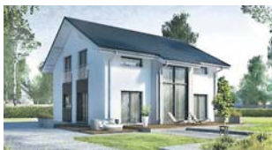
ab 228.500 € Fertighaus Alfa 162 | 162,36 m²
