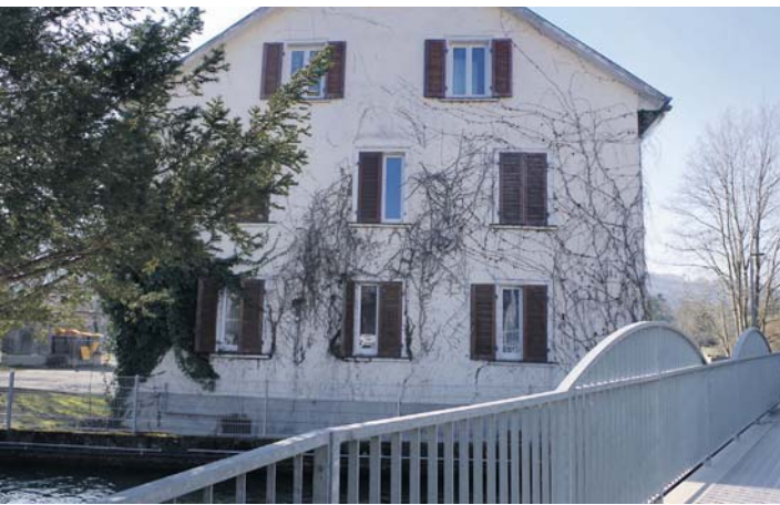
Wegen Einsturzgefahr nicht bewohnt ist dieses Wohnhaus am Worblinger Aachkanal. Es soll nun für die Anschlussunterbringung Geflüchteter standfester gemacht werden. swb-Bild: of
