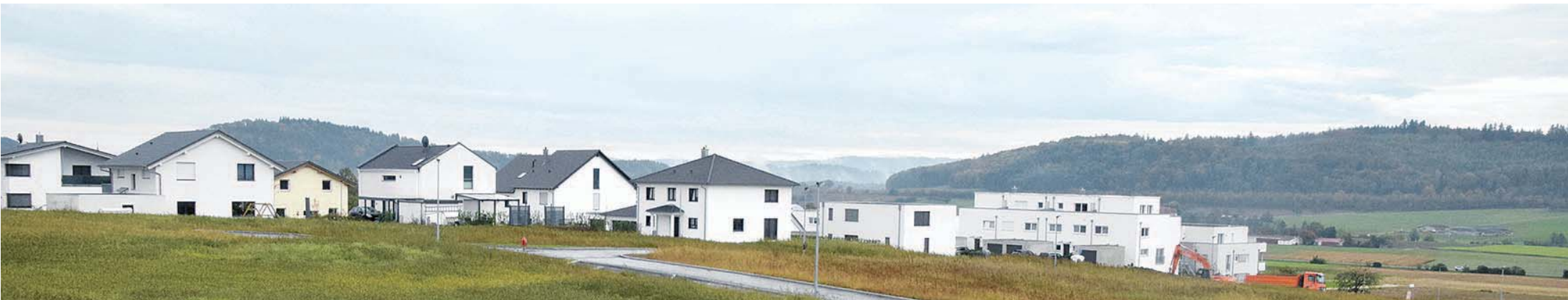
Neubaugeliete wie »Beim Steppbachwiesle« in Hilzingen werden weiter notwendig sein, um die Wohnungsnot zu mildern und dem Wunsch nach Eigenheimen nachzukommen.
