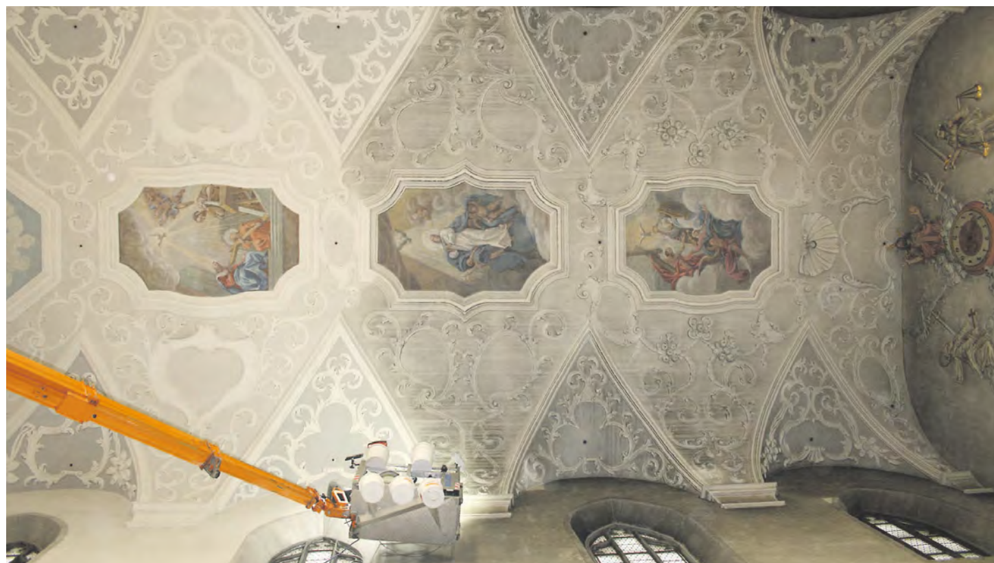
Die Wände und Decken des Radolfzeller Münsters wurden mit Latexgranulat abgestrahlt, um sie zu reinigen. Der linke Bereich der Decke des Hauptschiffs ist auf dem Bild bereits gesäubert, rechts sieht man noch den unbehandelten Zustand. swb-Bild: Siegelin
