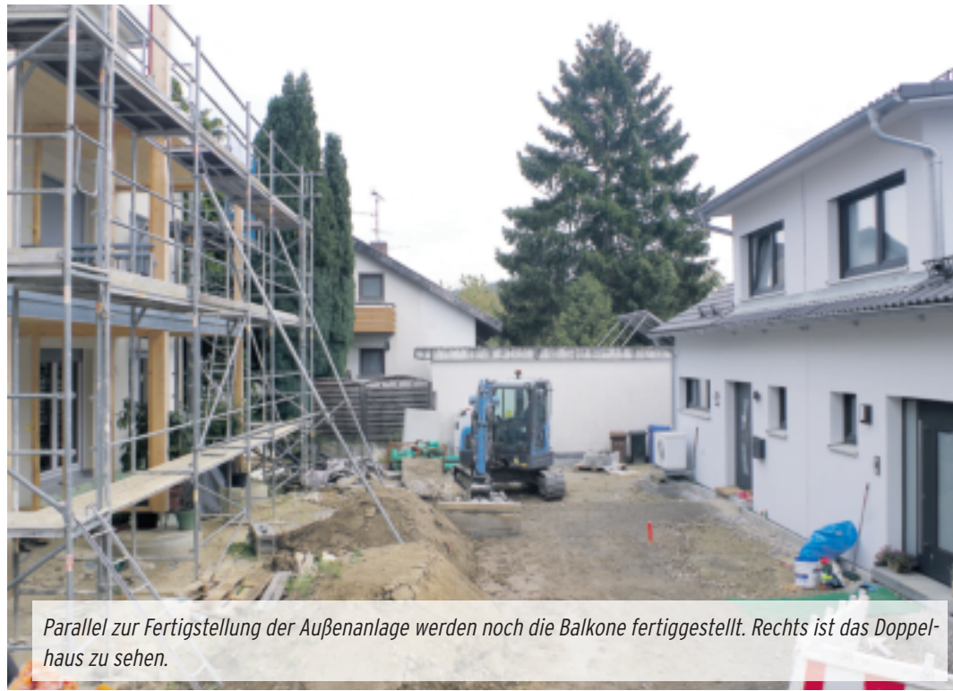
Die Aktivierung einer Baulücke für Wohnungsbau durch einen privaten Investor ermöglichte die Schaffung eines Wohnhauses und einem Doppelhaus durch das Unternehmen Burkard Hausbau/Renchen - es ist ein Holzständerbau.
