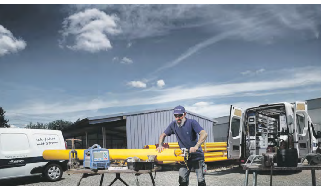
Vorbereitende Arbeiten an einem PE-Rohr zur künftigen Versorgung mit Wasserstoff.
