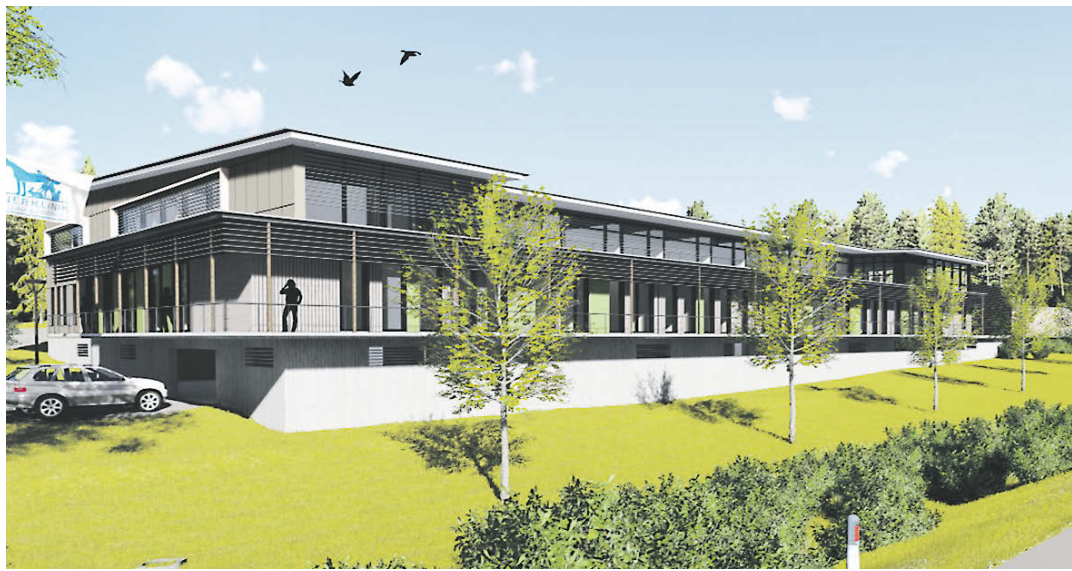
Am östlichen Ende des interkommunalen Gewerbegebiets Blumhof soll die neue Tierklinik nun entstehen. Prägend ist das dreigeschossige Gebäude der Kleintierklinik, das auf einer Tiefgarage erstellt wird, um die Hanglage zu überwinden.
