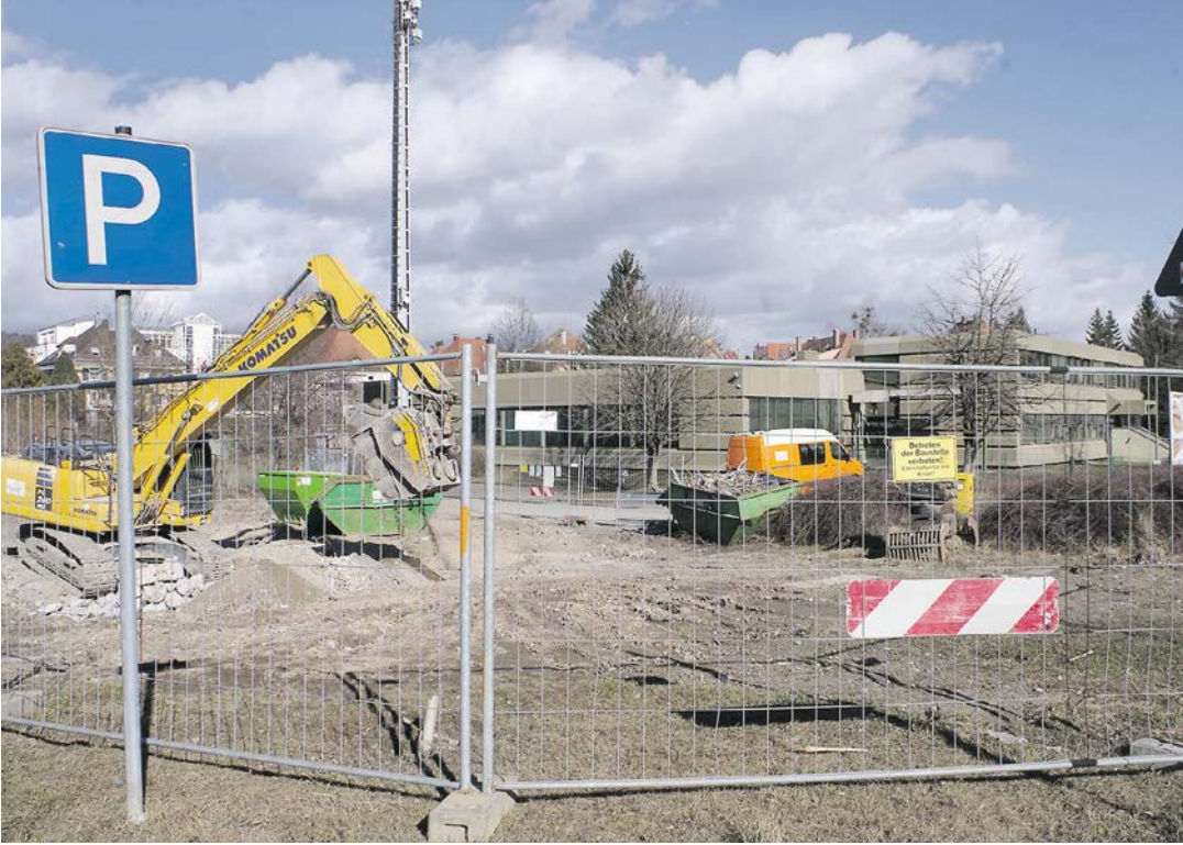
Auf dem Areal des Telekomgebäudes, wo schon Rückbbauarbeiten begonnen haben, soll ein großer Wohnpark entstehen, mit höhen bis zu 20 Metern.
