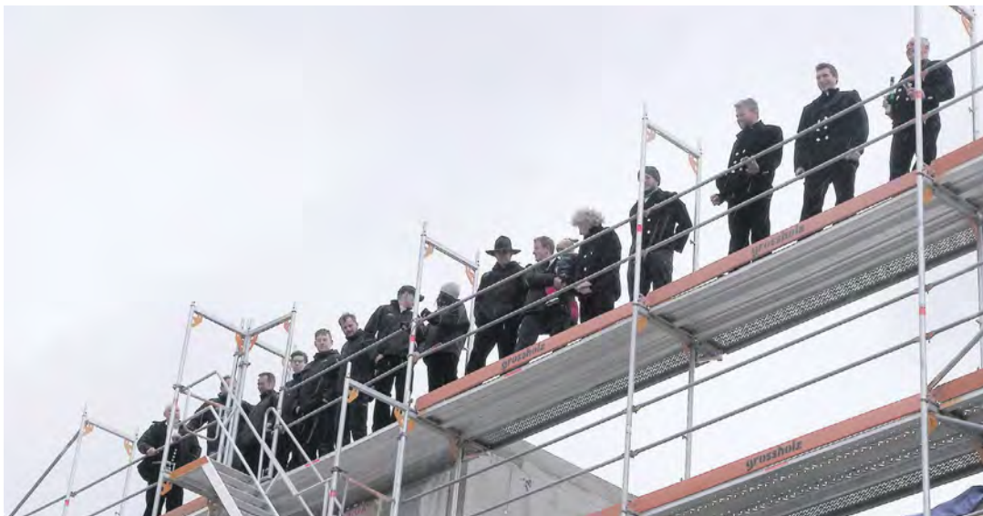
Die Mannschaft der Stockacher Zimmerei Kiefer zeigte sich mit dem kompletten Team windfest zum Richtspruch des WiGe-Projekts in Radolfzell.
