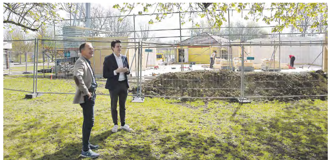
Zahlreiche Förderprojekte werden in Tengen umgesetzt. Bürgermeister Marian Schreier und Landtagsabgeordneter Hans-Peter Storz machten sich vor Ort ein Bild von der Entwicklung der Randenstadt. Im Bild bei der Baustelle des neuen Bürgersaals, der gerade am Kastaniengarten entsteht. swb-Bild: mu
