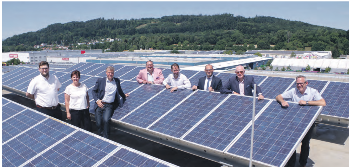
Auf dem Dach des DAK/Constellium-Bürohauses zeigt sich, was hier schon an Flächen für Sonnenstrom genutzt wird und was noch möglich wäre. Im Bild (vorn) „Hausherr“ Patrick Dürrholdt (Fraser Property) , Birgit Falser und David Bücheler (Transco) , und hinten Andreas Zeiser-Radtke (SZR) , Bürgermeister Dr. Michael Klinger , Matthias Bentz (PIC Immobilien) , Hans-Peter Repnik (3R) und Wirtschaftsförderer Thomas Schleicher .
