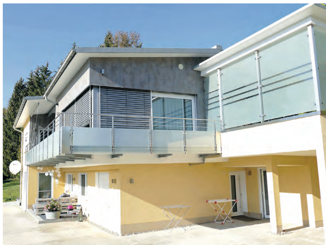
Umbau eines Einfamilienhauses.
